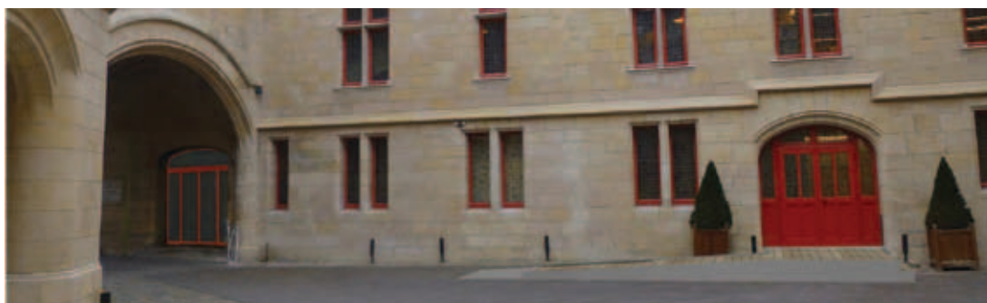
L'ancien accès aux salles d'exposition (à gauche) devient l'entrée publique de la bibliothèque par portes coulissantes automatiques. À droite, rampe pour l'accès des handicapés © Ville de Paris.
