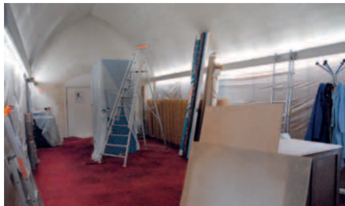
La réserve des affiches du 3 e étage dégagée temporairement pour la pose d'une porte coupe-feu et divers aménagements
