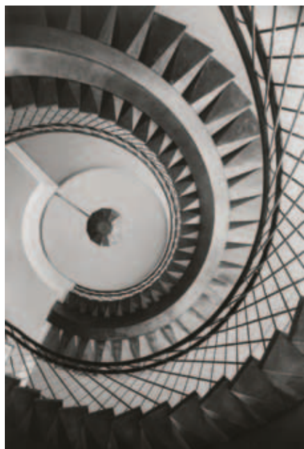
Paul Henrot. Escalier de l'Insitut de la sidérurgie (St Germain-en-Laye). Négatif souple. 1953. D.R. © MAD Paris / Photo C. Dellière
